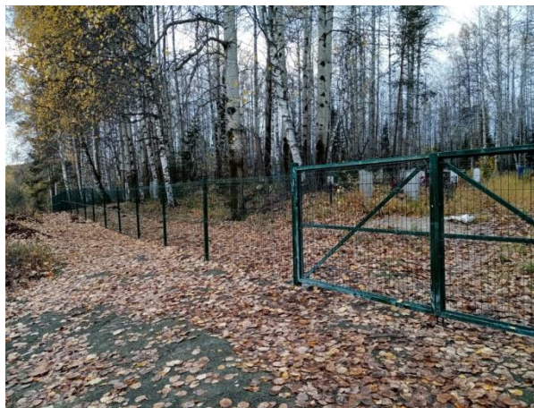
Установка ограждения на кладбище (п. Бельск)
