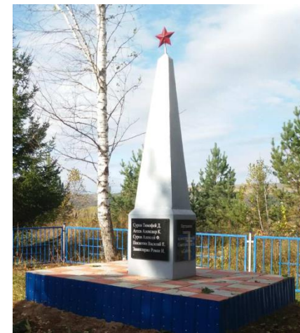
Ремонт мемориала (с. Устье)
